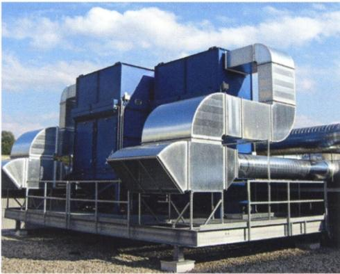
Пылеочистка установки термического нанесения покрытия с тепловой рекуперацией, объемный расход 2X 15 000 м³/ч.
