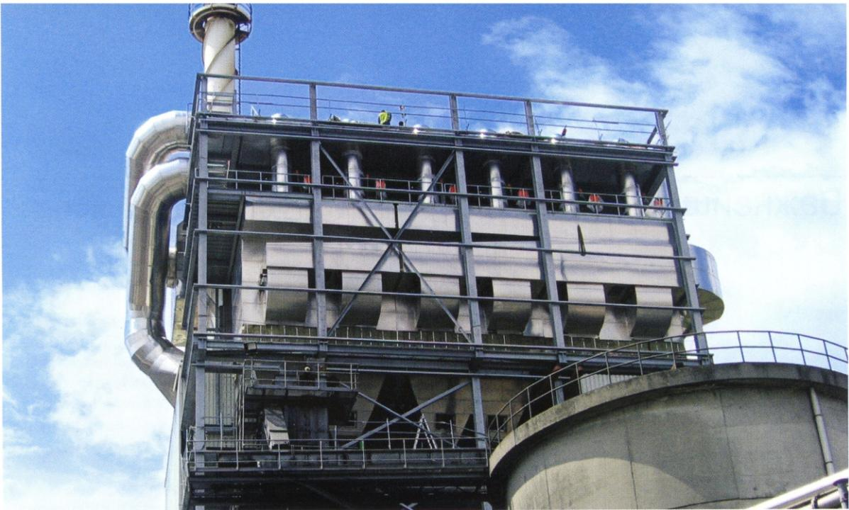
Очистка дымовых газов угольной печи со сжиганием побочных продуктов, с подачей присадок и утилизацией летучей пыли. Общая производительность: 165 000 м<sup>3</sup>/ч при рабочей температуре 160 °С.
